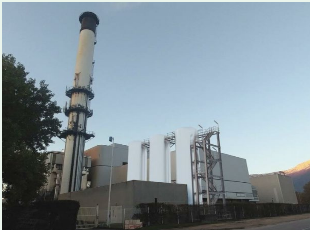
Citernes de stockage d'eau chaude
