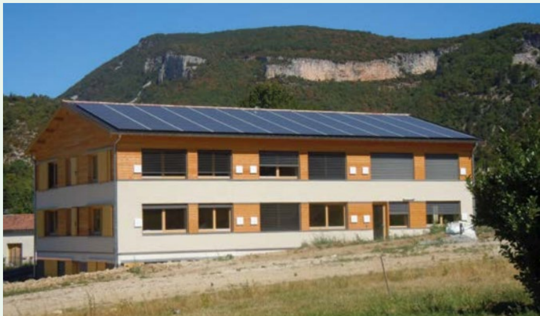
Bâtiment LowCal d'Enertech – Crédit : Enertech
