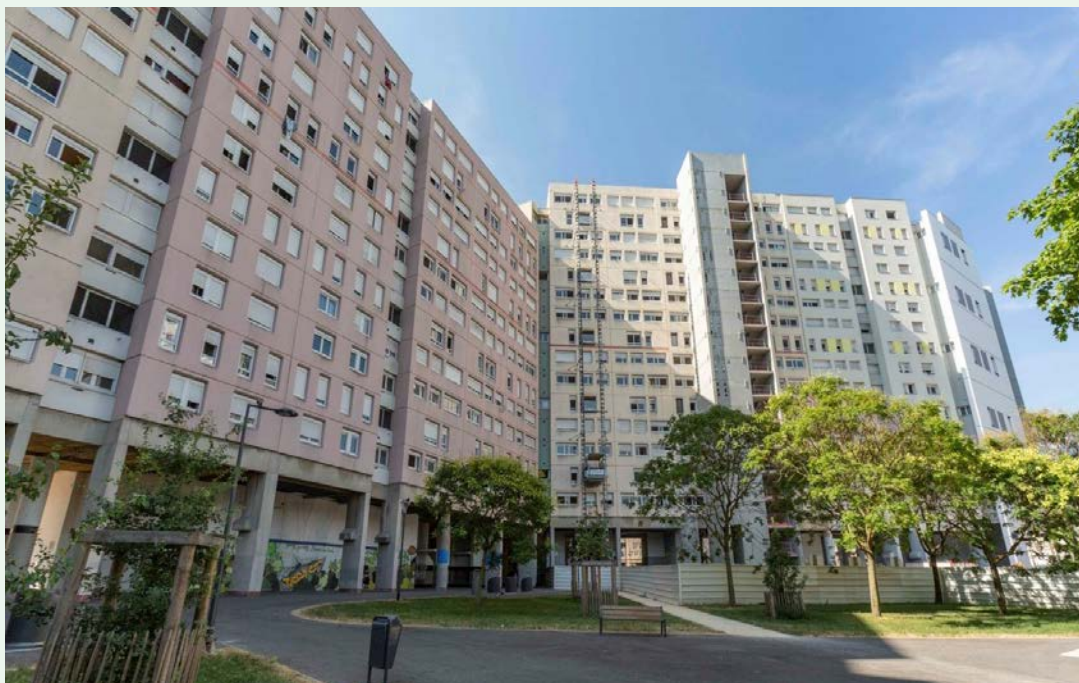
Logements sociaux aux Villeneuves – Crédit : Grenoble-Alpes Métropole
